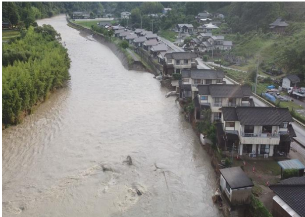
【護岸流失】万江城内地区
