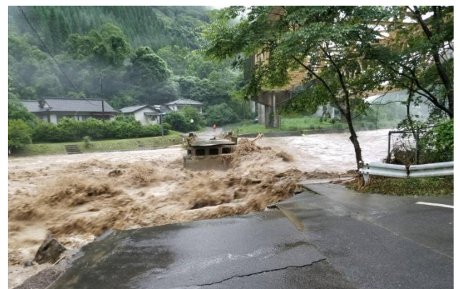
【橋梁流失】万江足算瀬地区
